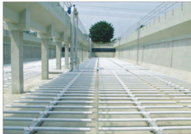
配置Magnum® 2000 FLEXSIL® 薄膜管式曝气设备的曝气池
