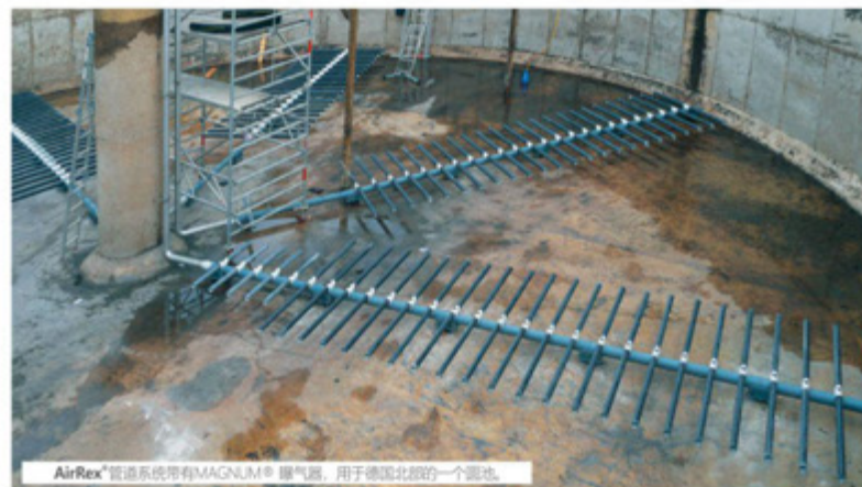
AirRex®管道系统带有MAGNUM®曝气器，用于德国北部的一个圆池。
